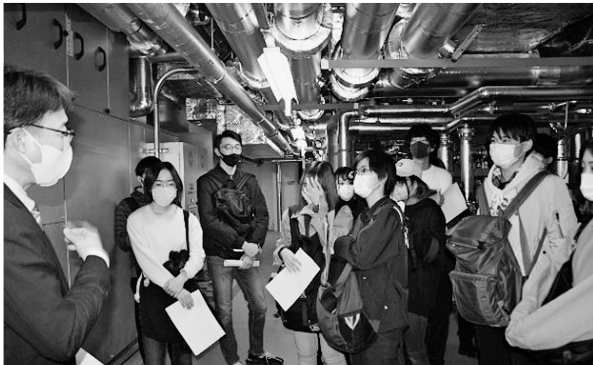
写真3 市庁舎機械室の見学
